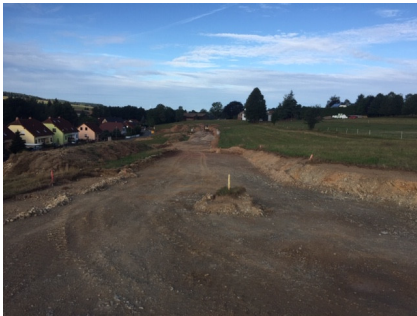
Absteckung Schmutzwasserkanal
