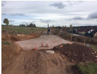
Alle Medien eingelegt, Frostschutzaufbau Straße Beginn Granitbordverlegung
