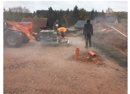
Alle Medien eingelegt, Frostschutzaufbau Straße Beginn Granitbordverlegung
