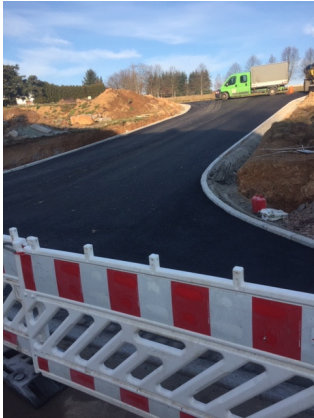
fertige Zufahrt ins neue Wohngebiet
