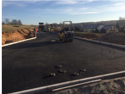
Herstellung Tragschicht Wohngebietsstraße
